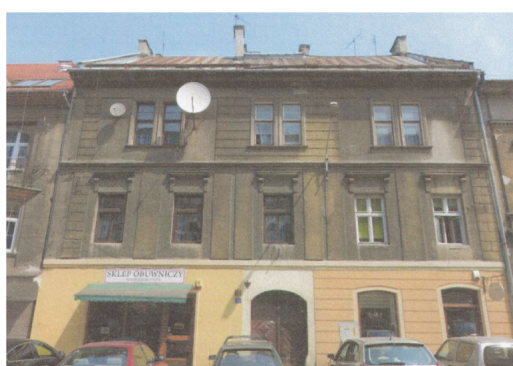
Rys. 1. Widok elewacji frontowej od ul. 11 Listopada przed wykonaniem prac renowacyjnych
